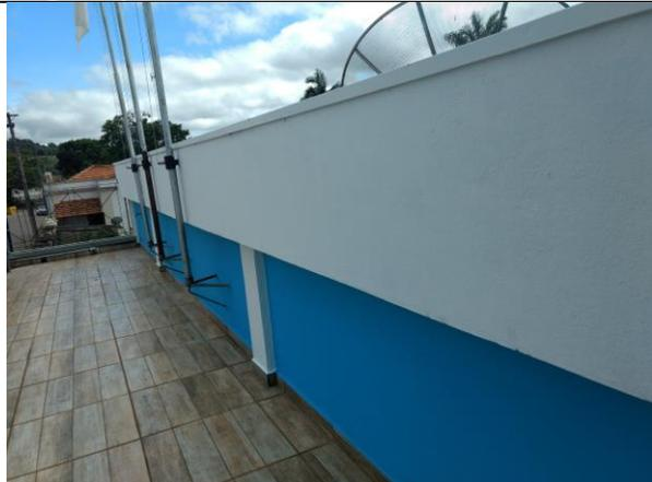
Descrição: reparos nas infiltrações e pintura em tinta látex acrílica / duas demãos ou mais onde foi necessário para cobertura total, nas cores indicadas e aprovadas pela fiscalização após amostra (área externa).
