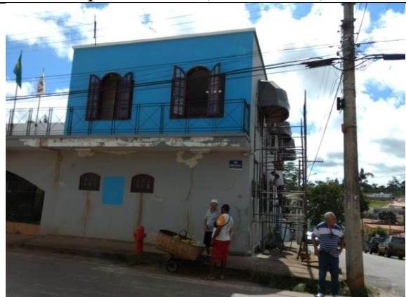
Descrição: os rebocos e tintas em desagregação estão sendo removidos, com aplicação de novos rebocos (área externa).
