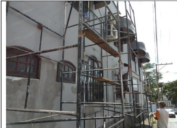
Descrição: os rebocos e tintas em desagregação estão sendo removidos, com aplicação de novos rebocos (área externa).
