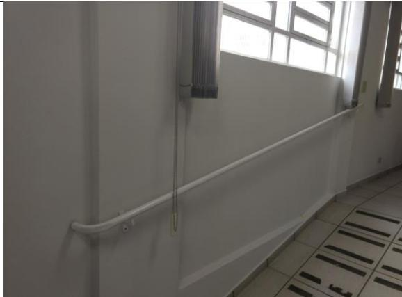
Descrição: reparos nas infiltrações e pintura em tinta látex acrílica / duas demãos ou mais onde foi necessário para cobertura total, nas cores indicadas e aprovadas pela fiscalização após amostra (área interna / Plenário).
