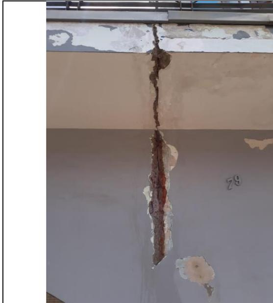
Descrição: reparos nas infiltrações, rachaduras e trincas, com aplicação de novo reboco (área externa / frente do prédio).
