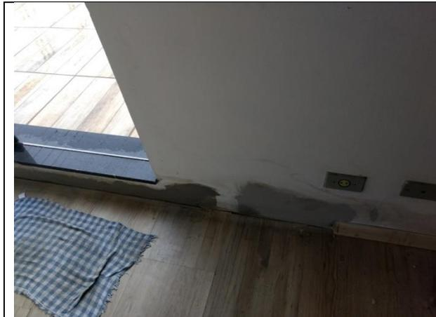
Descrição: os rebocos e tintas em desagregação estão sendo removidos, com aplicação de novos rebocos.
