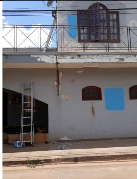
Descrição: reparos nas infiltrações, rachaduras e trincas, com aplicação de novo reboco (área externa / frente do prédio).
