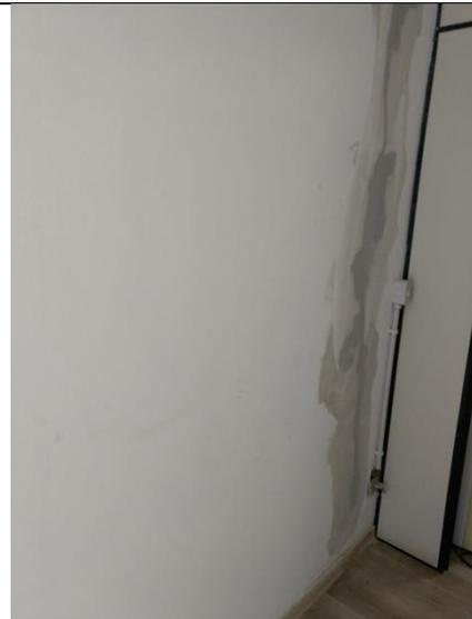
Descrição: os rebocos e tintas em desagregação estão sendo removidos, com aplicação de novos rebocos.
